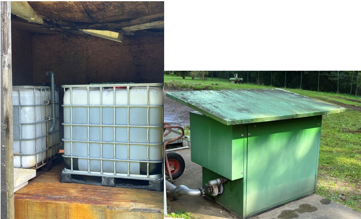
alte Fällmitteldosieranlage (IBC-Container in provisorischer Holz-Einhausung)
